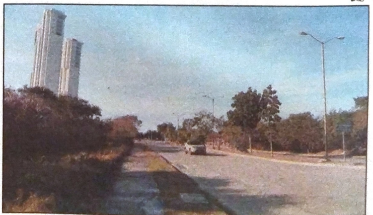
Las inversiones privadas para redensificación se insertan en áreas estratégicamente localizadas en la ciudad y gracias a ello se mejoran las infraestructuras, y precisamente por el aumento que tienen en su coeficiente de ocupación al construir varios niveles, se estima que la aportación del predial será proporcionalmente mayor y, como consecuencia, las finanzas municipales se verán beneficiadas, así como el resto de la ciudad.
