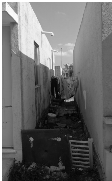
FIGURA 4 PASILLO LATERAL DE SEPARACIÓN ENTRE VIVIENDAS. SE OBSERVA POCO SOLEAMIENTO Y PRESENCIA DE HONGOS Y HUMEDAD
