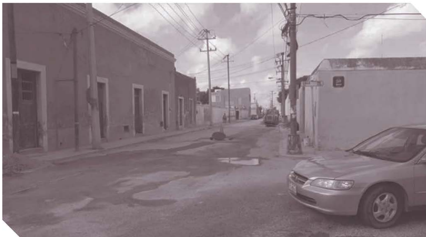
Figura 3 > Repavimentaciones en la calle 48 entre 57 y 59 del Centro de Mérida. Fuente: Archivo propio. Fecha: 12 de julio de 2017
