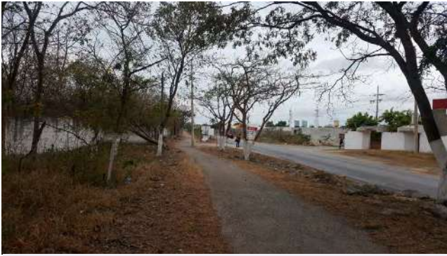
Tramo de la ciclopista de Cholul, proyecto inacabado al no incorporar los paraderos. También habría que valorar las condiciones de iluminación y seguridad que ofrece durante la noche.
