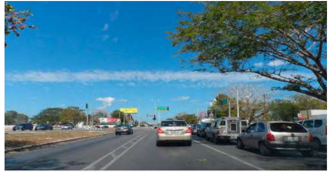
Vista desde el entronque a Liverpool-CORDEMEX hacia la salida a Progreso. No hay espacios seguros para que los usuarios de ambos lados de la vialidad puedan cruzar.
