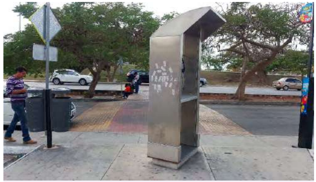
Caseta telefónica ubicada justo en el paso peatonal, con la intención de ser vista por cuestiones de publicidad, pero no con la visión de la seguridad que los peatones necesitan.
