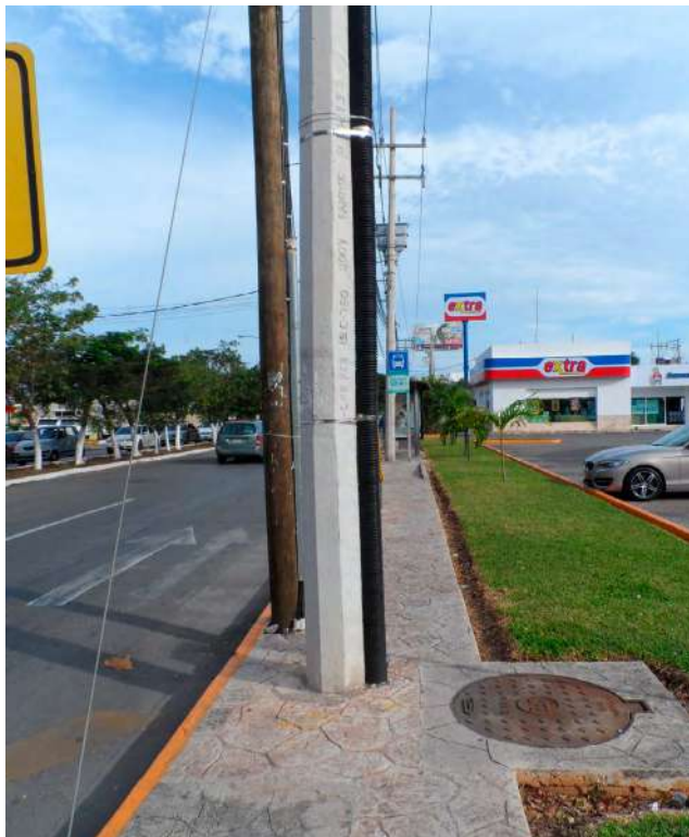
→ Obstáculos en la banqueta, postes, señalamientos, infraestructuras, espacio angosto para poder caminar en la Ave. García Lavín en la esquina con la Glorieta del Pocito.
