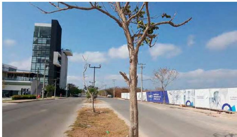
Frente a las torres departamentales de Sentinelo y Torre Onze y sobre la calle 24 se construye el Hospital Faro del Mayab. Cabe señalar que a lo largo de casi 3 kilómetros, desde el entronque a periférico hasta la Plaza de Temozón Norte, se desarrollan sólo propiedades en régimen de condominio, lo cual afecta en la conectividad y movilidad de la zona.
