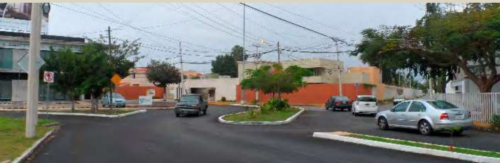
De Periférico hacia el Urban Center la calle 10 tiene diferentes anchos y características.
